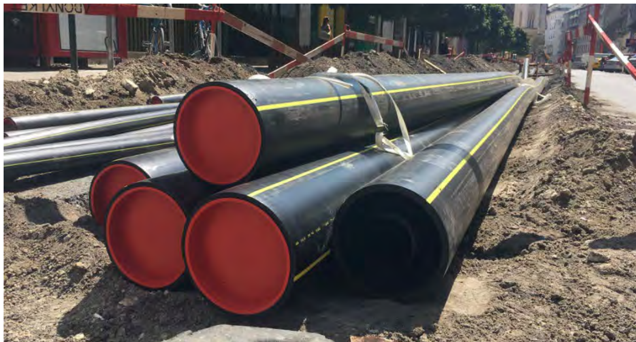
18. fotó: Gázvezeték rekonstrukció
