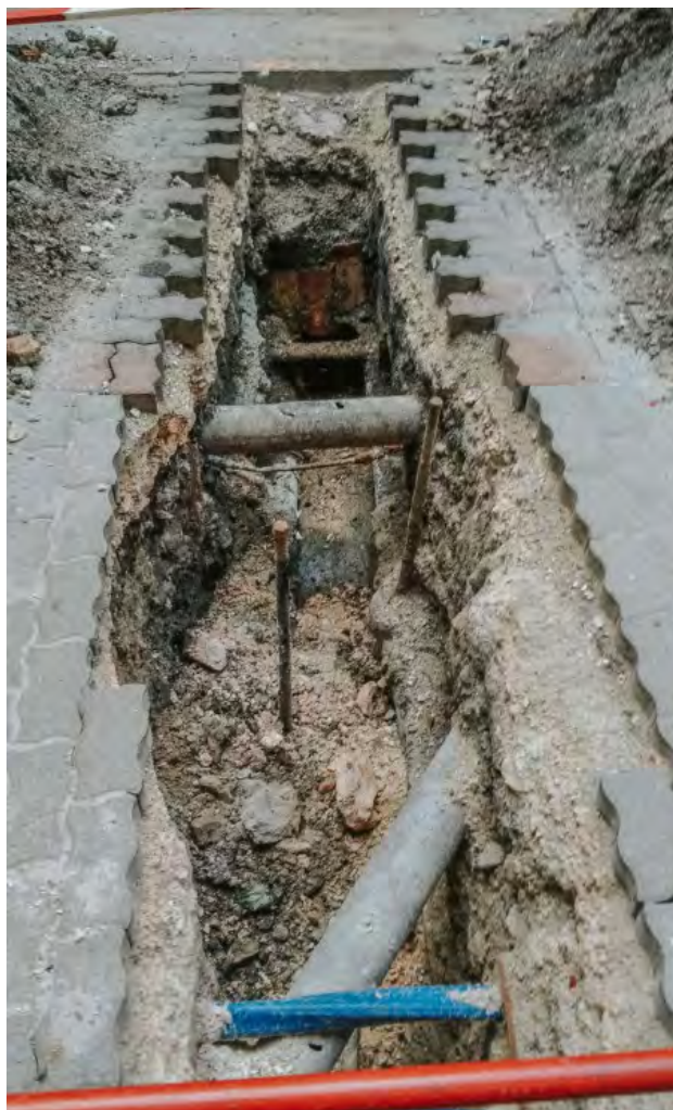
25. fotó: Gázvezeték rekonstrukció, Visegrádi utca, Budapest
