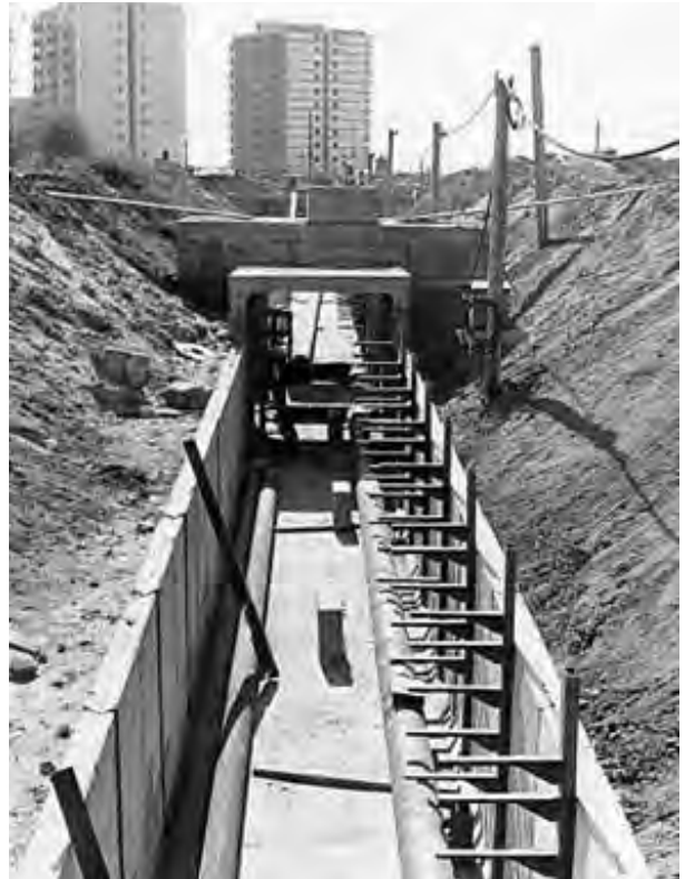
14. fotó: A pesterzsébeti közműalagút építése
