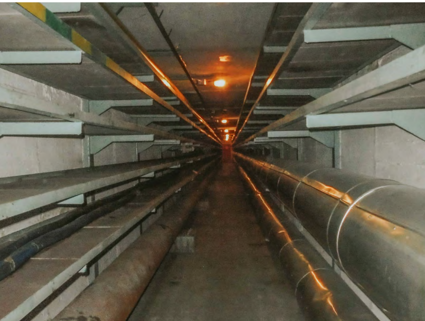
15. fotó: A pesterzsébeti közműálagút
