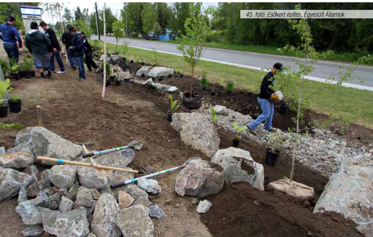
44. fotó: Új telepítésű esőkert túlfolyókkal, Egyesült Államok
