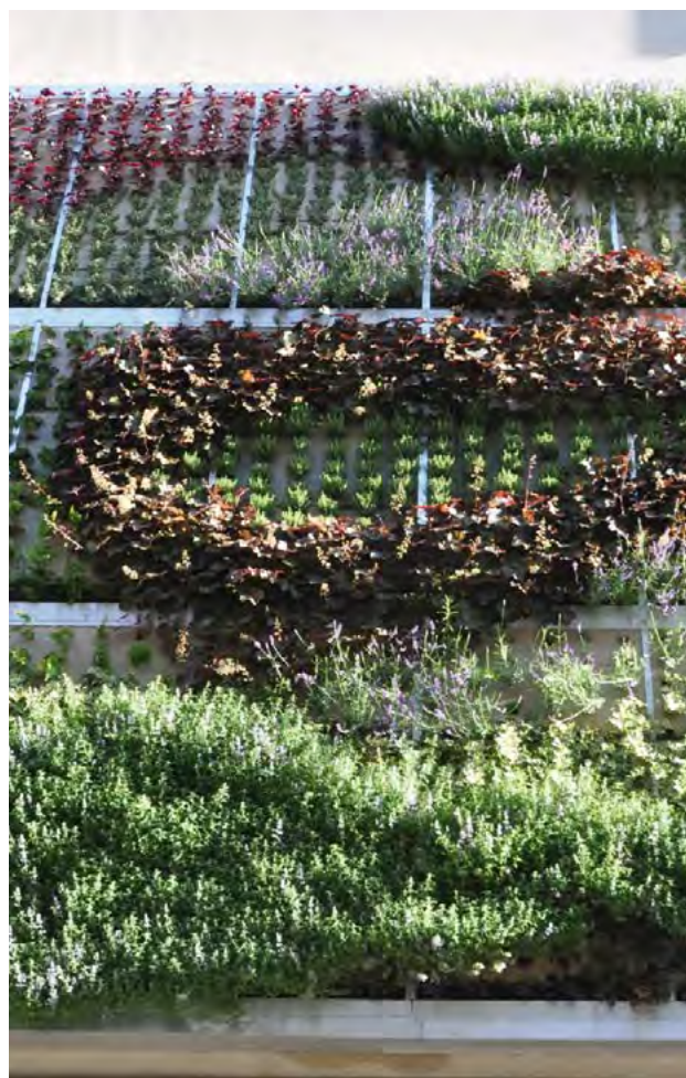
158–160. ábra Független gyökérszónás zöldhomlokzat beültetési képe és a növények fejlődése a begyökeresedési időszakban
