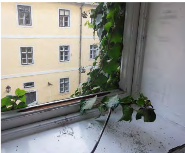
201–202. ábra Negatív fototrop hajtások a repedésekbe, nyílt hézagokba behatolva akár jelentős károkat is okozhatnak
