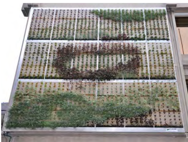
158–160. ábra Független gyökérszónás zöldhomlokzat beültetési képe és a növények fejlődése a begyökeresedési időszakban
