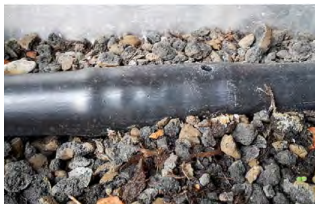
214–216. ábra Az öntözőrendszer elemei: központi rész, az ültetőelemeket ellátó csőhálózat, a vízutánpótlást biztosító csepegtetőcső
