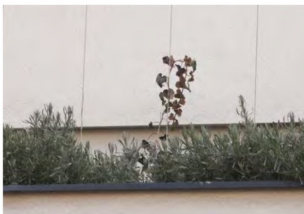
227–228. ábra Hibás támszerkezetválasztás: borostyán ( Hedera helix ) növekedése nem indul meg függőleges sodronykötetes támszerkezeten, a lonc nem alkalmas támszerkezet nélküli futtatásra
