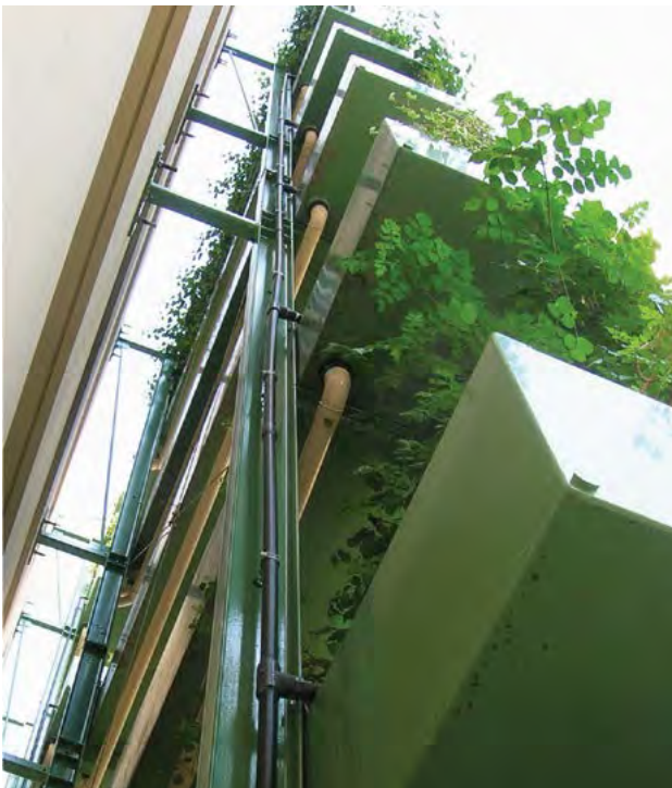
217–219. ábra A drénvízvezetés ültetőkonténereik és ültetőedény-soros rendszerek esetén dréncsővezetékekkel
