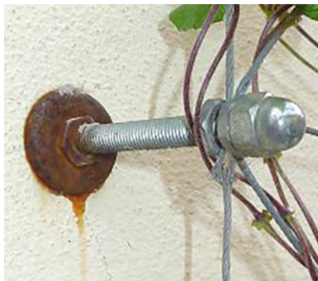
232. ábra Eleinte esztétikai, majd statikai gondot is okozhat egy nem megfelelően időjárásálló elem alkalmazása
