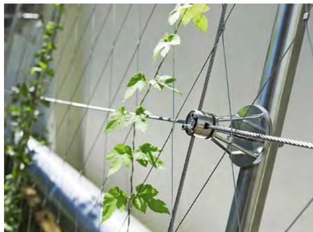
165–166. ábra Felületjellegű farács támszerkezet kaccsal rögzülő szőlő ( Vitis sp. ), illetve függesztett acélsodrony háló csavarodó növény esetén
