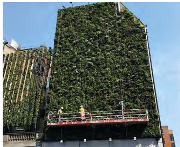
210–213. ábra Zöldhomlokzat karbantartása létrás, emelőkosaras, alpintechnikás és függesztett hidas megközelítéssel (két bécsi, budapesti és londoni épület esetén)
