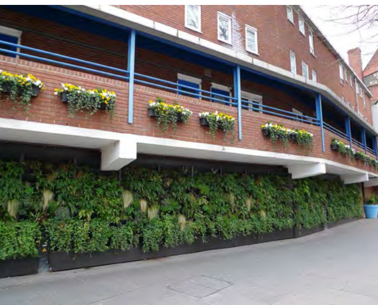
33. ábra Esővízgyűjtő tartállyal kombinált zöldhomlokzat – a szűrt esővíz biztosítja a növények vízutánpótlását (London)
