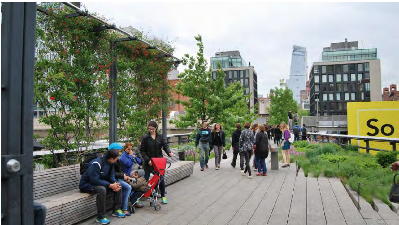
23. ábra High Line Park 1,6 km 2 területű nyilvános park Alsó-Manhattanben (New York), amit a hajdani West Side Line magvasút helyett alakítottak ki 2006–2014 között
