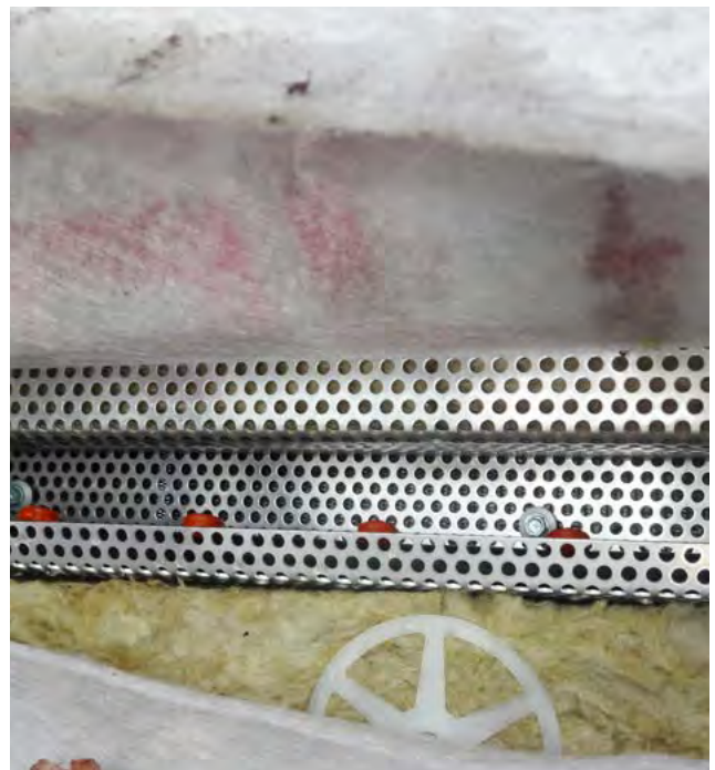
181–183. ábra Különböző ültetőközegek: szervetlen örménnyel feltöltött kazetta, zöldfalban alkalmazható filc (technikai textília) és kőzetgyapot egy filces rendszerben
