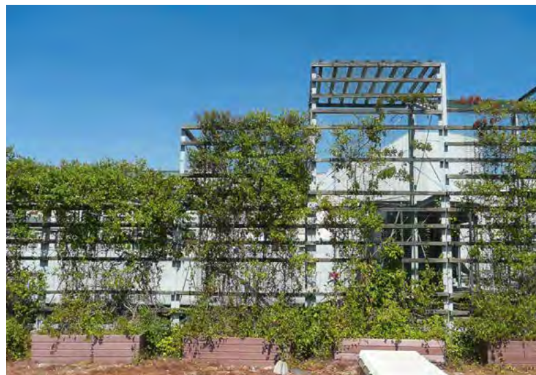
43–46. ábra Terepszinten elhelyezett planténerben (Berlin belvárosa), talajból (templom – Baden bei Wien, lakóépület – Erlangen) és zöldtető ültetőközegéből (IKEA áruház, Budapest) eredő kúszónövényekkel kialakított zöldhomlokzatok
