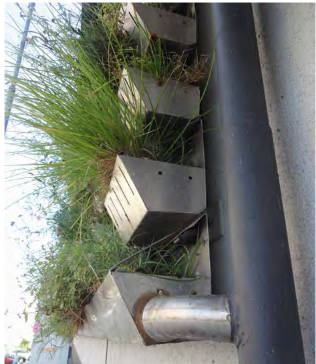
217–219. ábra A drénvízvezetés ültetőkonténereik és ültetőedény-soros rendszerek esetén dréncsővezetékekkel
