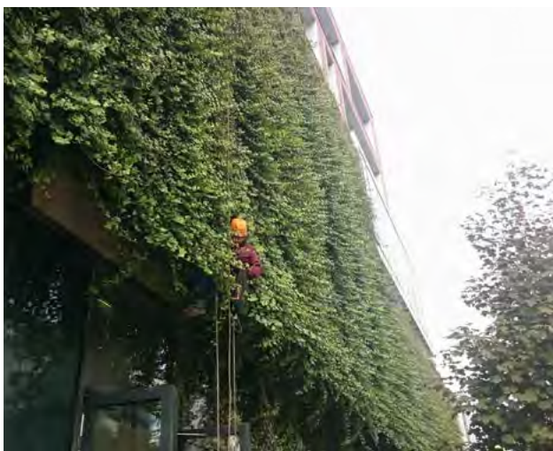
210–213. ábra Zöldhomlokzat karbantartása létrás, emelőkosaras, alpintechnikás és függesztett hidas megközelítéssel (két bécsi, budapesti és londoni épület esetén)
