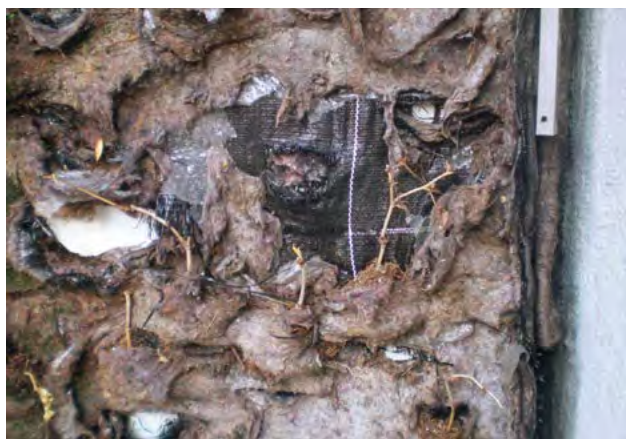
224–226. ábra Üzemeltetés hiánya a zöldfal visszafordíthatatlan tönkremenetelét okozhatja
