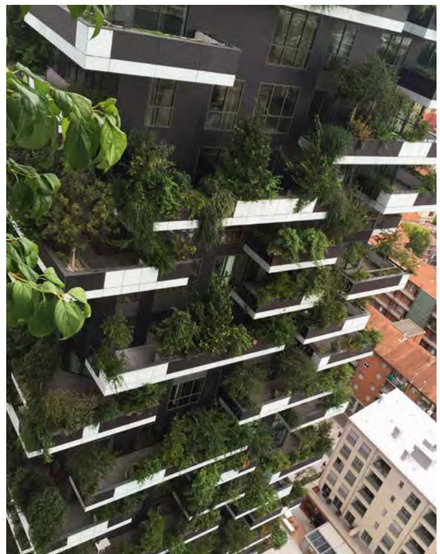
174–176. ábra Hőszigetelés nélküli és hőszigetelt rozsdamentes acél ültetőkonténerek, illetve a szerkezet részeként kialakított zöldtetőjellel, nagyméretű vasbeton ültetőkonténerek (Bosco Verticale, Milánó)
