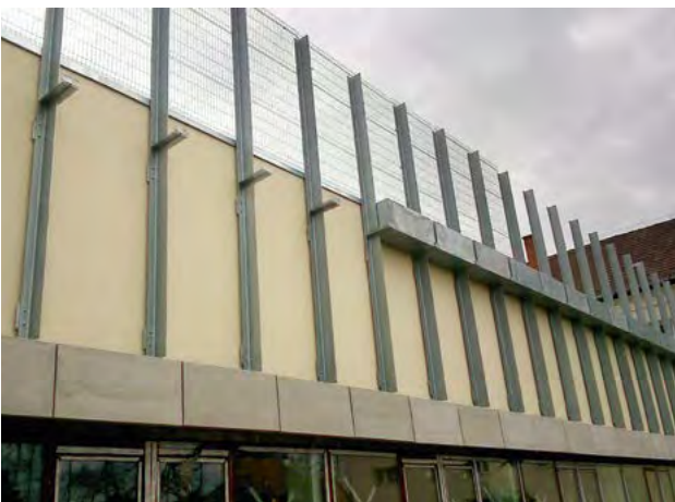
177–178. ábra Planténerek statikailag méretezett függőleges és vízszintes vázszerkezethez rögzítve
