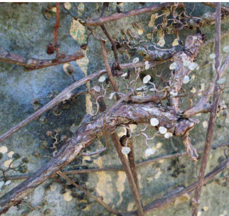
200. ábra Nem megfelelő tapadószilárdság esetén a kapaszkodó légygyökér és tapadókorong leválhat a felületről, ami a kúszónövény leszakadását okozhatja
