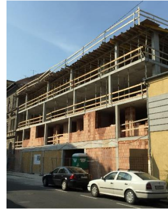
Építkezési munkák a kivételre kerülő telken (2018)
