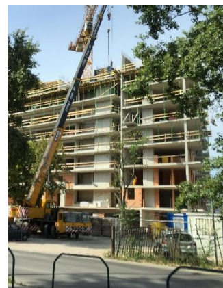
Építkezési munkák a kivételre kerülő telken (2018)
