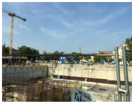
Építkezési munkák a kivételre kerülő telken (2018)
