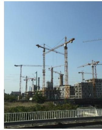
Építkezési munkák a kivételre kerülő telkeken (2018)
