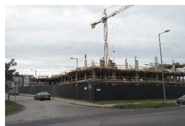
Folyamatban lévő építkezés (2018)
