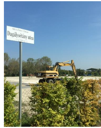
Építkezési munkák a kivételre kerülő telken (2018)
