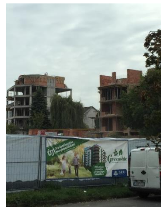
Építkezési munkák a kivételre kerülő telken (2018)
