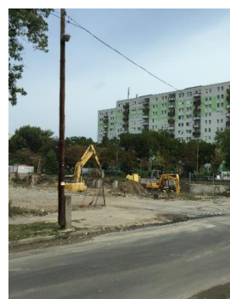
Építkezési munkák a kivételre kerülő telken (2018)
