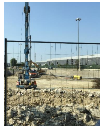
Építkezési munkák a kivételre kerülő telken (2018)
