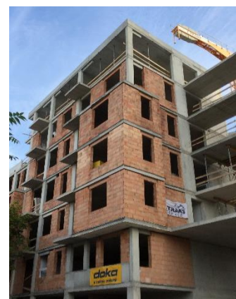
Építkezési munkák a kivételre kerülő telken (2018)
