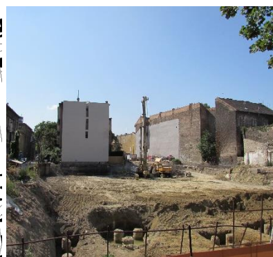
Fénykép a Corvin projekt építési területéről (2018)
