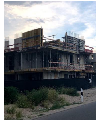
Építkezési munkák a kivételre kerülő telkeken (2018)
