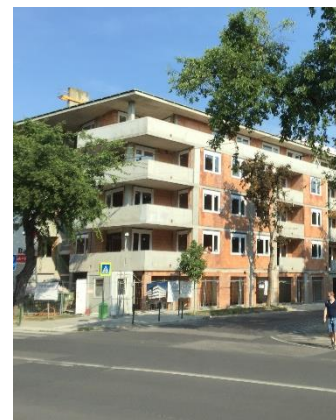
Építkezési munkák a kivételre kerülő telken (2018)
