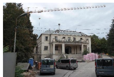
A Fácán vendéglő megújuló épülete (2018)
