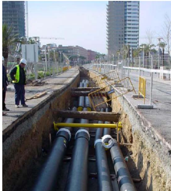
Előreszigetelt távfűtő és távhűtő vezetékek fektetése közös munkaárokban (Forrás: inpal.com)
