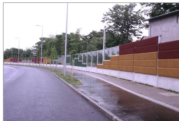
Csepeli gerincút zajvédelme (forrás: BKK Zrt.)
