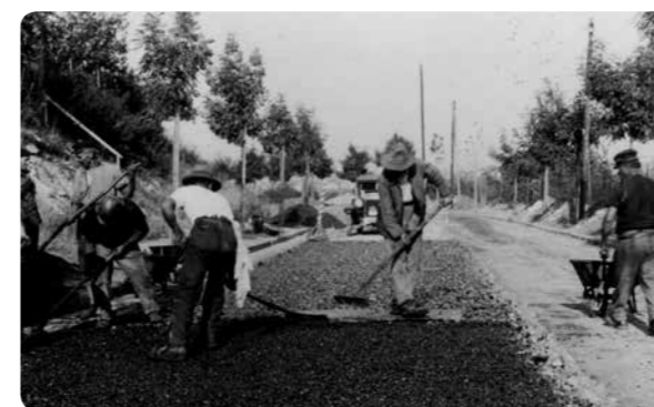
59. kép A Kútvölgyi út aszfaltozása
