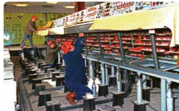
117. kép A szemétegető építése
