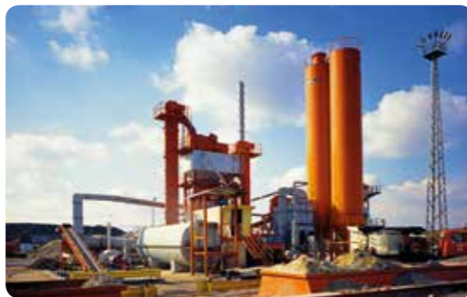
94. kép Lőrinci úti aszfaltgyár
