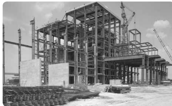
116. kép A szemétegető építése
