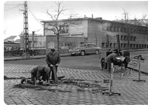
88. kép Útburkolat-javítás
