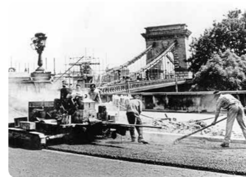
95. kép Linnhoff-rendszerű aszfaltegyengető gép
