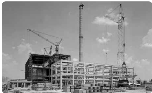
115. kép A szemétegető építése
