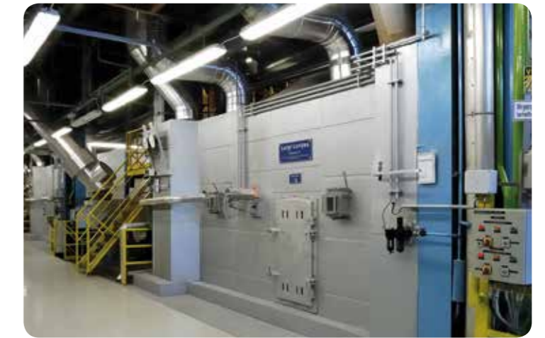
35. kép Kazánok a Hulladékhasznosító Műben
